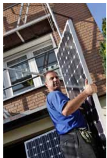
Milazim Rutke: Vom »Bau-Allrounder« zum Solar-Facharbeiter
